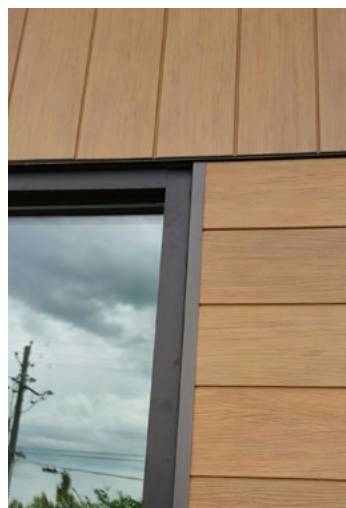
Exemples de joints de contrôle/à compression installés
